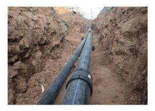
2D-2 排水管网系统(雨、污、粪管)
