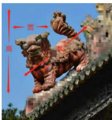
答：按设计图示尺寸的外形体积以“m<sup>3</sup>”计算，不扣除空隙部分体积（如右图高×宽×长）。
